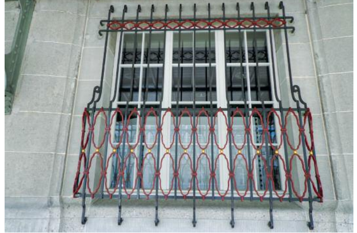
Das rekonstruierte Gitter samt Fenster. Die Farbigkeit des Gitters wurde bereits im Jahr 2015 untersucht und hier entsprechend dem ursprünglichen Erscheinungsbild wieder ausgeführt.
