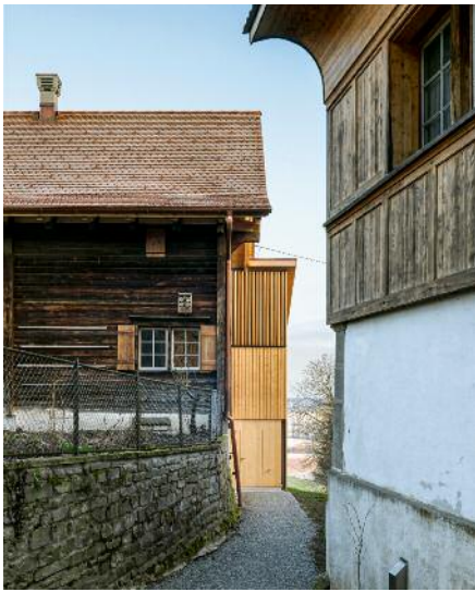
Enge und Weite – je nach Perspektive – charakterisieren das Haus am Rand des Weilers.
