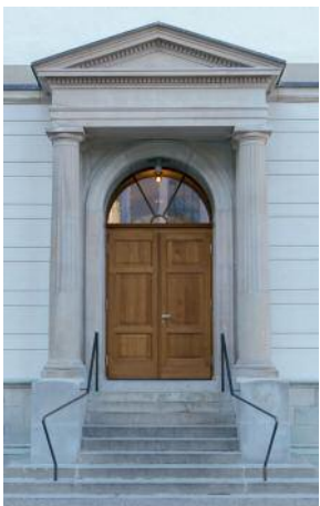
Der barrierefreie Zugang beim Haupteingang hätte eine vollständige Veränderung des Säulenportikus erfordert. Zur Verbesserung wurde dieser mit einem beidseitigen Handlauf ergänzt sowie ein neuer hindernisfreier Zugang auf der Nordseite geschaffen.
