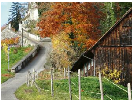
Vor der Renovation: Der eingewachsene Torkel neben der steilen Auffahrt zum Schloss.
