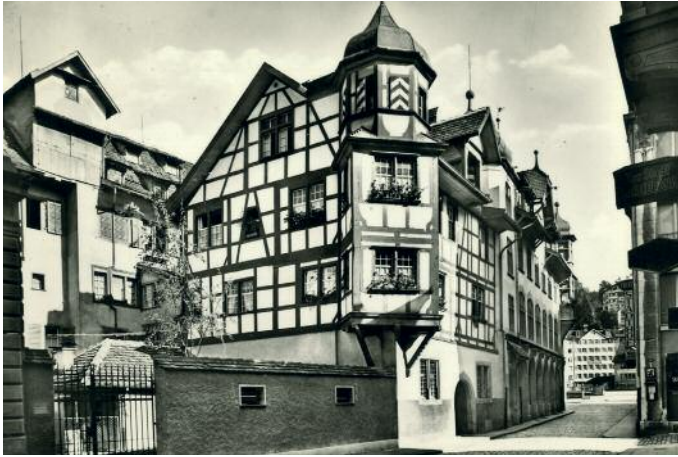
Aufnahme um 1906 mit wohl rotbrauner Riegelfassung. Quadratisch im Grundriss weist der Portnerhof über dem massiv gemauerten Erdgeschoss zwei Obergeschosse in Fachwerk auf und präsentiert an der Nordwestecke einen malerischen Eckerker, der im Dachbereich von einem achteckigen Türmchen gekrönt wird.
