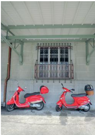
Die rekonstruierte Fensteröffnung in der Gesamtansicht.
