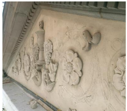
Giebelrelief während der Rekonstruktion. Leider konnten keine Spuren des originalen Zustands gefunden werden. Die Wiederherstellung erfolgte auf der Basis von historischen Fotografien und einer im Archiv gefundenen Skizze von Oechslin. Die Tiefenwirkung und der Detaillierungsgrad mussten dazu mehrmals aus der Distanz überprüft werden. Grössere Teile wurden in der Werkstatt vorgefertigt und vor Ort durch die Blattgirlanden ergänzt.
