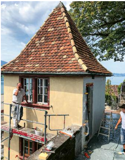
Auftrag des neuen Kalkputzes.
