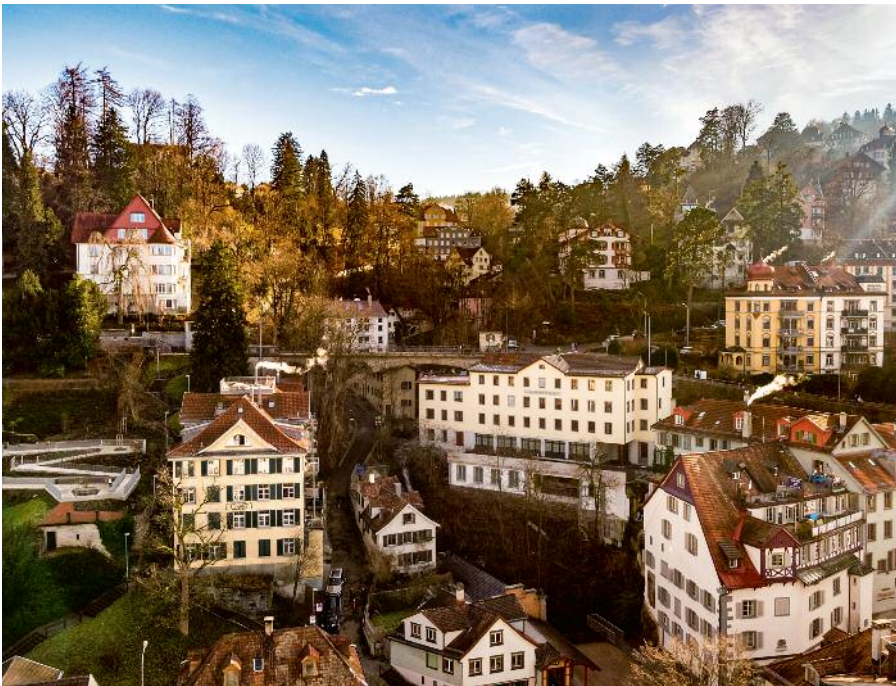
Im Mühlegg-Tobel in der Stadt St.Gallen treffen frühe Industriebauten und Erschliessungsbauwerke aufeinander. Die Brücken und Stützmauern sind Teil der städtischen Infrastruktur, die Bauten Zeugen der Industrialisierung. Auch hier spielt Höhe eine entscheidende Rolle.
