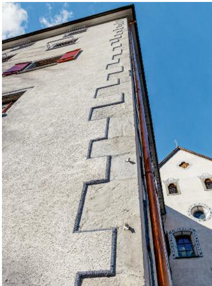
Das Sichtbarmachen der Eckquader bedingte das Anbördeln des neuen Verputzes.
