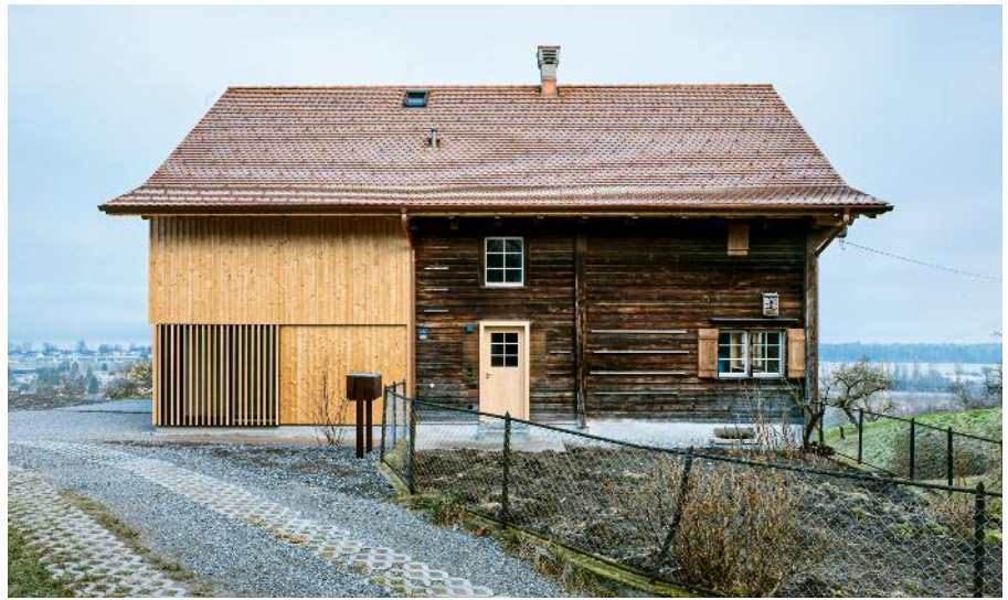
Der neue Anbau nimmt den Querschnitt der ehemaligen Stallscheune auf, ist aber deutlich kürzer.
