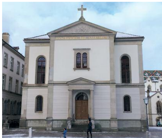
Durch die Rekonstruktion der Bandrustika konnte die ursprüngliche Architektur wiederhergestellt werden. Der neue Putzaufbau gestaltete sich als schwierig, da zwischen historischem Kalkputz und fast reinem Zementputz fast alle Arten des Grundputzes vorhanden waren. Aus Kostengründen und zur Schonung des Mauerwerks wurden gut haftende Grundputze belassen und nur der Deckputz durch einen Kalkputz erneuert.
