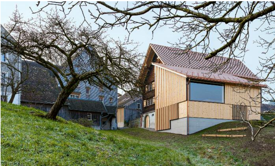
Ansicht von Nordosten mit dem Ersatzbau des Schopfs.
