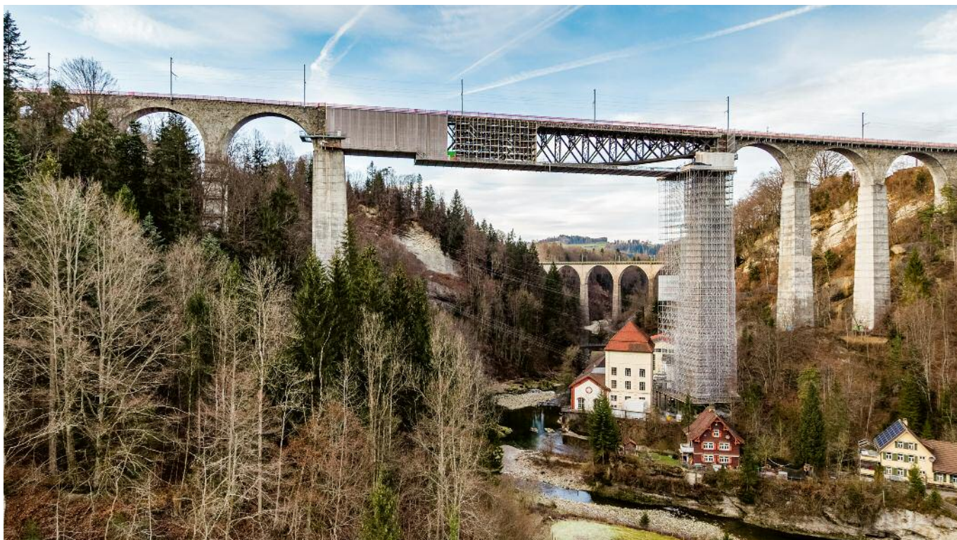
Ingenieurbauwerke und Kunstbauten weisen oft schon aufgrund ihrer Nutzung eine grosse Höhe auf. Besonders Brücken, Stauauern und Viadukte stellen die Denkmalpflege vor besondere Herausforderungen und spezifische Fragen. Sittertobel St.Gallen.
