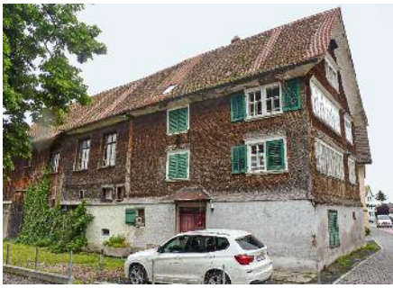
Der Adler vor der Renovation, mit der alten Scheune, deren grosse Fenster den Saal verraten.
