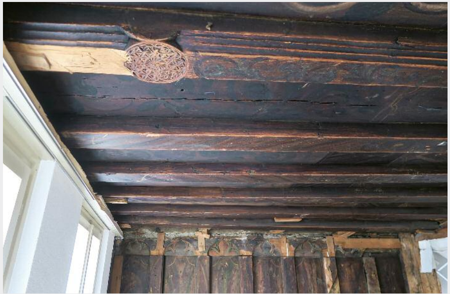
Gotische Bohlenbalkendecke in Lichtensteig. Foto: Kantonale Denkmalpflege / Moritz Flury-Rova.
