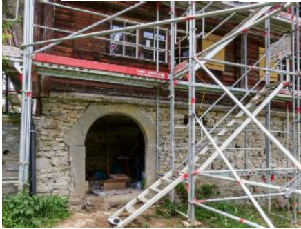
Das Sockelmauerwerk nach dem Abschlagen des Verputzes. Foto: Matthias Mutter, Bad Ragaz.
