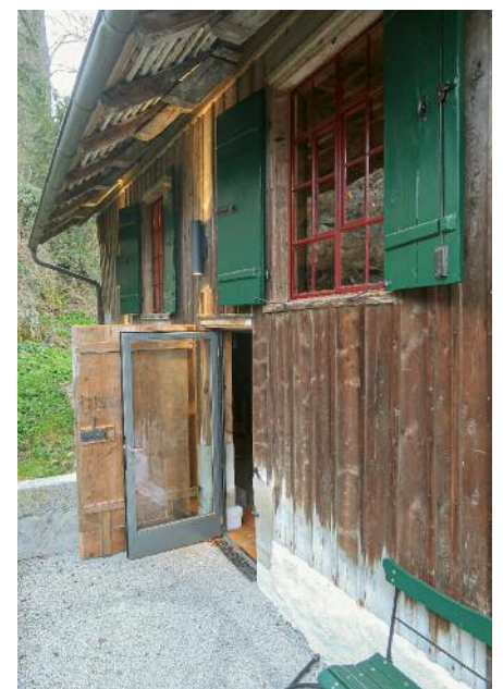
Südfassade mit wohl zweihundertjährigem Fenster und altem Fensterladen; die historische Tür erhielt eine dezente moderne Ergänzung auf der Innenseite.
