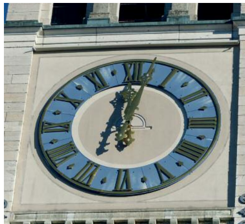
Neben den eigentlichen Bauteilen der Turmuhr ist auch das Verteilgetriebe der Transmission auf die Zeiger restauriert worden.
