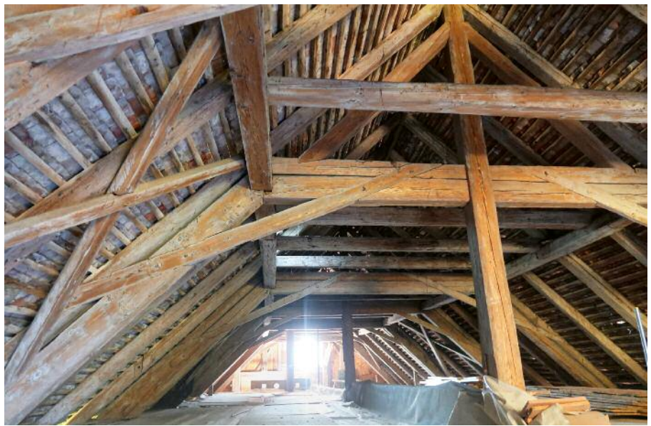
Der mächtige Dachstuhl von 1576 mit den charakteristischen Kopfbändern mit Sägezahnblättern. Blick nach Osten; an der hier sichtbaren Bundebene mit Sprengwerk beginnt die Nummerierung der Abbundzeichen neu.
