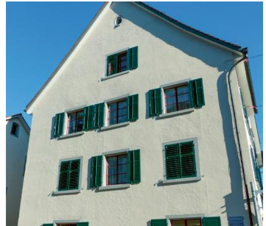
Westfassade nach der Renovation 2019. Auf eine Gesamterneuerung des Verputzes wurde verzichtet. Das Mauerwerk wurde somit nicht freigelegt und verbirgt nach wie vor viele Geheimnisse früherer Bauepochen. Es bleibt den nachfolgenden Generationen überlassen, die bedeutende und abwechslungsreiche Geschichte weiter zu erforschen.
