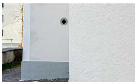
Der neue, historisch korrekt feinkörnige Kalk- putz am Turm hebt sich vom grobkörnigeren, klosterputzartigen Zementputz der letzten Renovation am Kirchenschiff ab.
