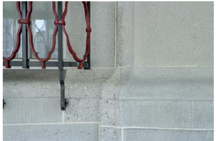
Von nahem ist die Flickstelle durchaus erkennbar, auch wenn versucht wurde, die Stücke aus Kunststein dem Bestand so ähnlich wie möglich herzustellen. Während die Ostfassade in Anlehnung an den Hauptbahnhof mit Sandstein verkleidet ist, besteht die Verkleidung bei den anderen drei Fassaden aus Kunststein.
