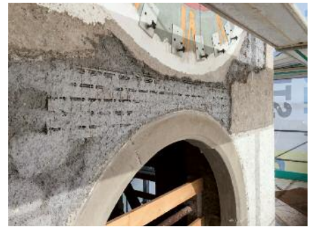
Am Turm wurde der Verputz vollständig ent- fernt.
