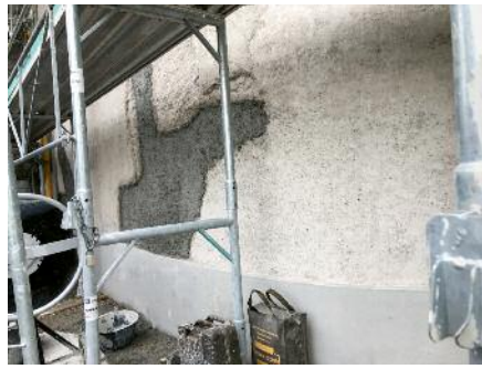
Reparatur am Verputz des Kirchenschiffs.
