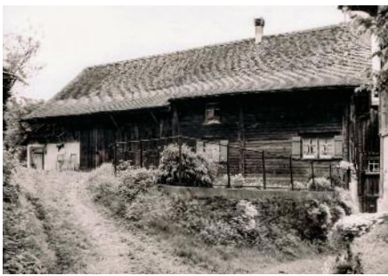
Historische Fotografie vor dem Abbruch der Stallscheune in den 1960er-Jahren.
