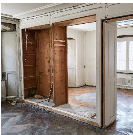
Das erste Obergeschoss bei Beginn der Renovationsarbeiten. Foto: Kantonale Denkmalpflege.
