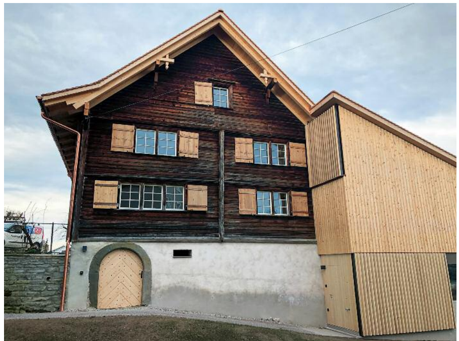
Die Hauptfassade mit dem frisch verputzten Sockel. Foto Kantonale Denkmalpflege.
