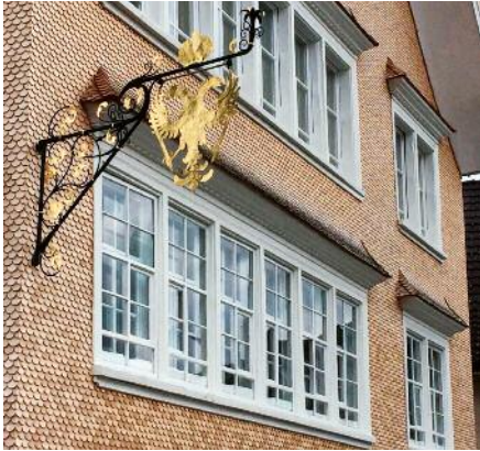
Die neu geschindelte Fassade mit den restaurierten Schieberlifenster und dem alten Wirtshausschild.
